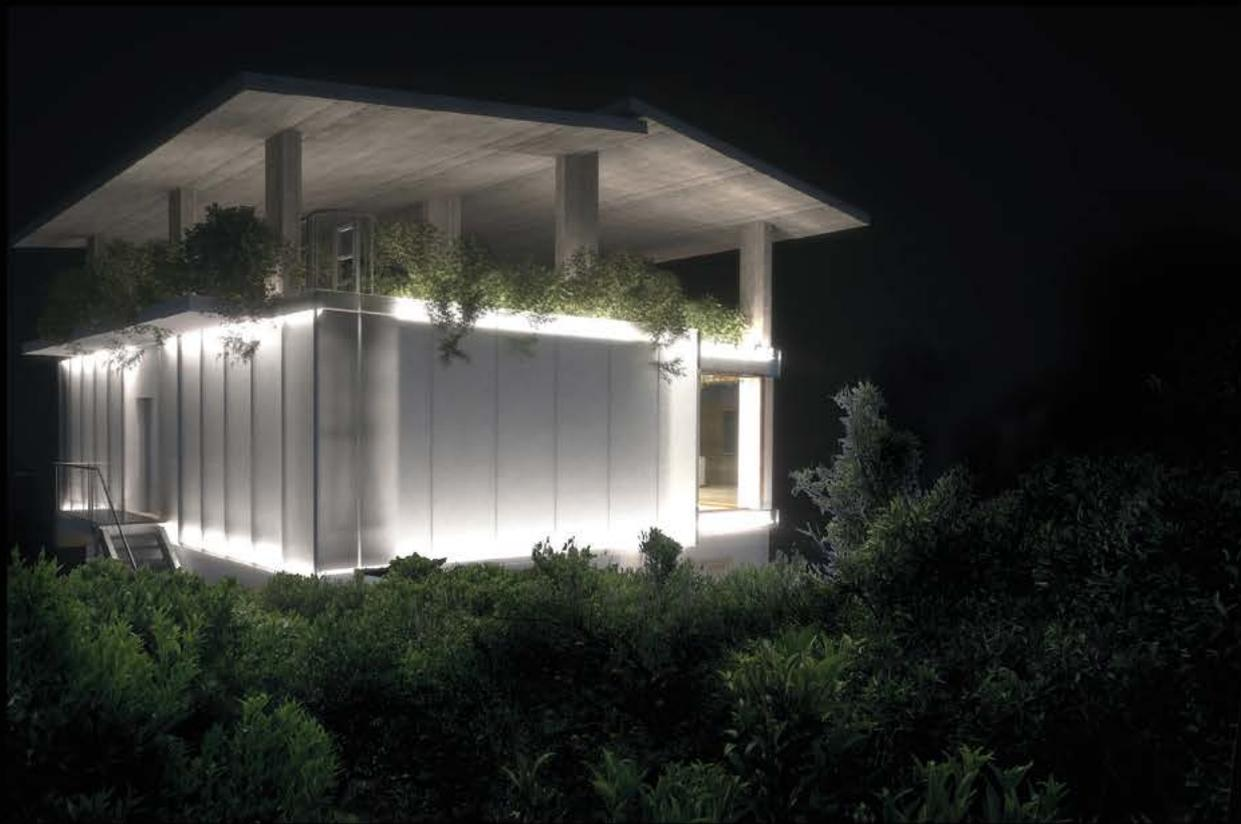
e la semitrasparenza del policarbonato hanno permesso l'inserimento di un sistema di illuminazione continuo per l'intera superficie dei fronti, conferendo al progetto un forte connotato simbolico durante le ore di buio. Per lo smaltimento delle acque nere e bianche si è dotato l'immobile di un impianto di fitodepurazione adeguatamente calcolato sulle attività polivalenti della sala principale posta al livello 1.
