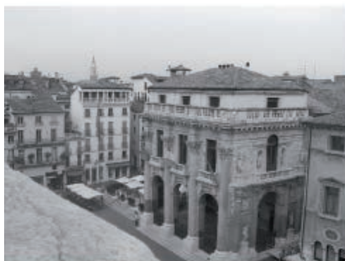
Fotografia Stato di Fatto
