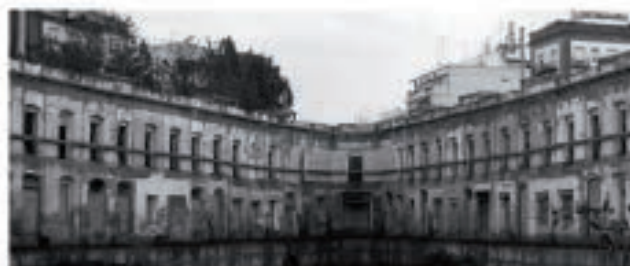
Vista interna muro perimetrale
