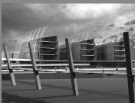
INGRESSO ALLA SCUOLA LATO PIUME
