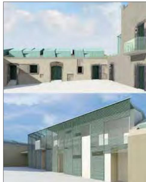
L'ala ovest (in alto) è definita dall'inserimento di autonome capsule abitative in legno lamellare rivestito in rame. L'ala est (in basso) è completata e risarcita dal nuovo inserimento volumetrico realizzato in legno lamellare
