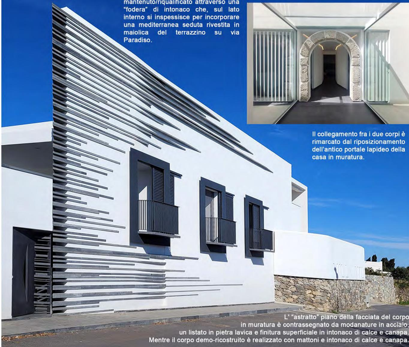
L' "astratto" piano della facciata del corpo in muratura è contrassegnato da modanature in acciaio, un listato in pietra lavica e finitura superficiale in intonaco di calce e canapa. Mentre il corpo demo-ricostruito è realizzato con mattoni e intonaco di calce e canapa.
