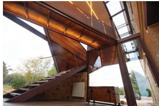
corridoio e collegamento verticale. La forma della struttura di collegamento in acciaio corten e vetro è stata suggerita da alcune macchine e strumenti agricoli di fine '800 - inizio '900, ancora presenti nell'edificio; testimonianza del passaggio all'era delle macchine anche nel mondo rurale. La particolare forma dall'addizione è stata ispirata da una vecchia trebbiatrice.
