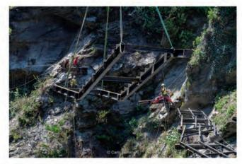
Operazione di fissaggio delle strutture delle nuove passerelle alle pareti rocciose dell'Orrido con squadre di montatori specializzati per lavori in acrobatico Foto Carlo Borlenghi
