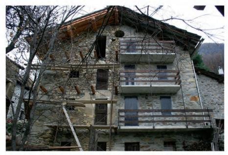
fig. 1 - Esempio di affiancamento di un intervento "moderno" su edificio rurale. Si nota la mancata attenzione alla presenza dell'intonaco, seppure residuo, nella nuova progettazione
