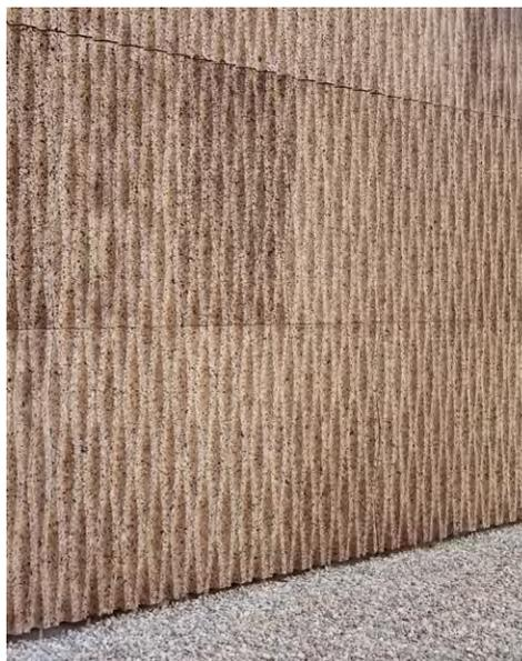
Dettaglio rivestimento esterno in sughero pantografato
