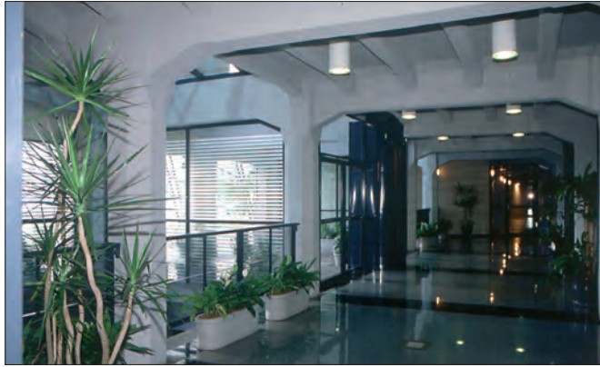
Particolare di un interno con la preesistente struttura intelaiata a vista
