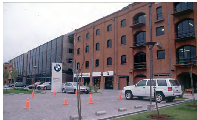
L'edificio ricostruito con inserimento dei nuovi volumi
