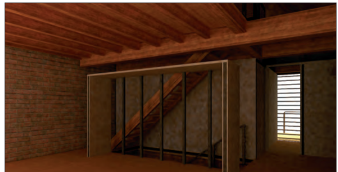
Interno blocco shop-house: piano primo (house)
