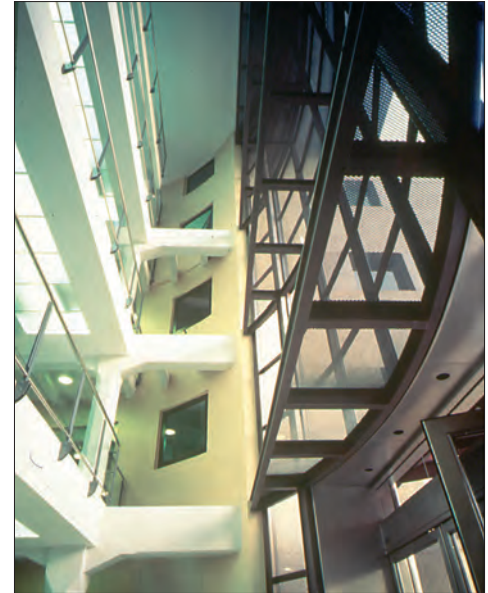
Particolare dell'innesto delle nuove strutture con le preesistenti
