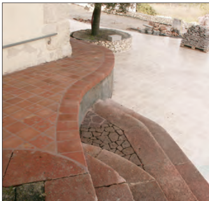
Particolare dell'ingresso alla chiesa durante la costruzione
