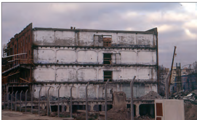
Terzo edificio prima dell'intervento
