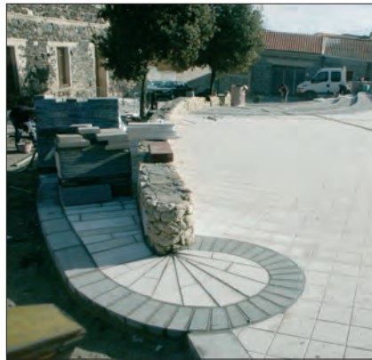
Particolare durante la costruzione
