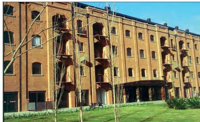
Secondo edificio recuperato, a carattere residenziale
