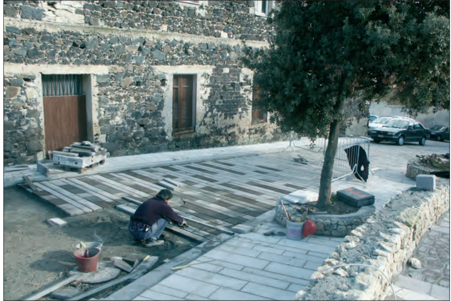
Particolare durante la costruzione
