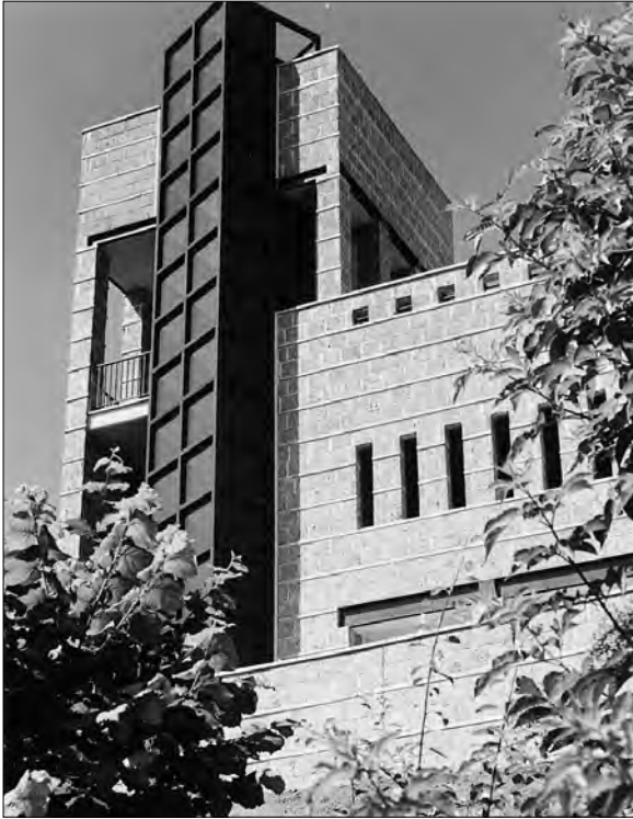
Particolare del corpo dei servizi
