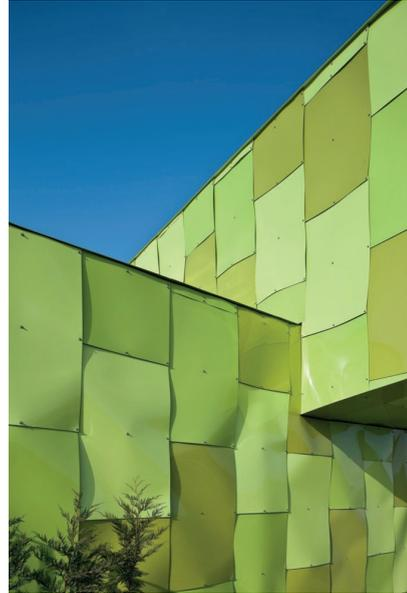
fig. 4 - 'Urban Stomach' Huarte, Spagna 2011 - Particolare *patchwork* delle pannellature rigonfie a membrana doppia, preposte ad ammortizzare ed insonorizzare l'organismo tecnologico interno
