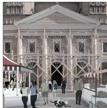
Camerino. Strutture lignee sulla facciata del Duomo, post sisma 2016
