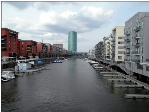
fig. 3 - Palazzine sul Molo Ovest del Porto (Westhafenpier), 2004
