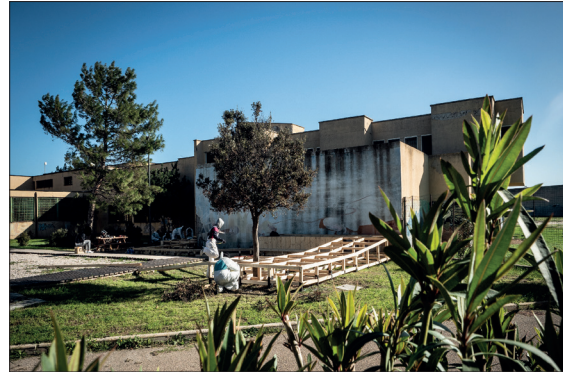
Messa in opera dello scheletro
