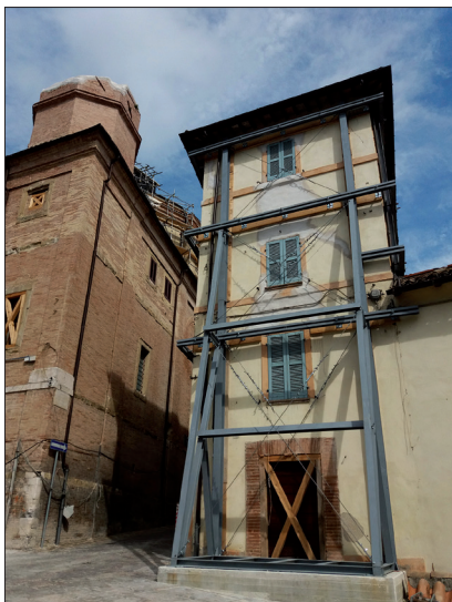
Camerino. Resti del torrino della chiesa di Santa Maria in Via e opere provvisorie post sisma 2016
