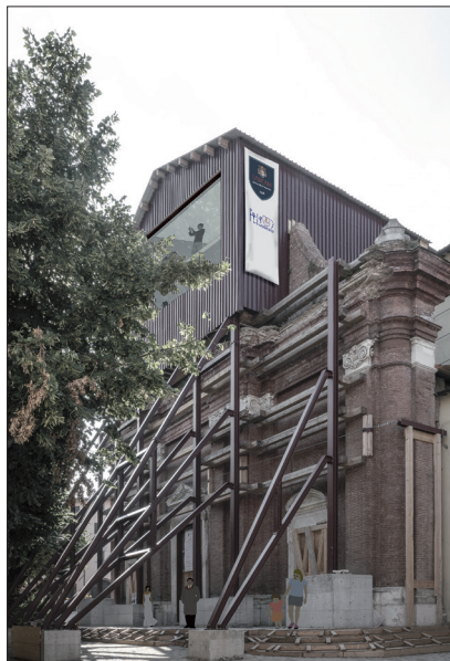
Camerino. Strutture di contenimento della chiesa di San Filippo, post sisma 2016
