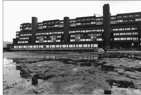
Uno sguardo sulla periferia. Gabriele Basilico, Complesso residenziale 'Monte Amiata' al quartiere Gallaratese, 1973
