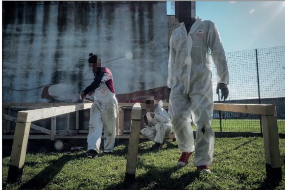
Collaborazione per l'impostazione del primo tratto della rampa
