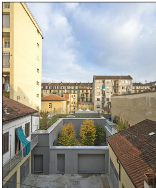
Il cortile alberato e il tetto giardino dopo l'intervento visto nel suo contesto
