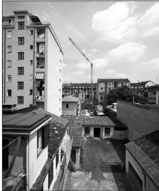
Il basso fabbricato e il suo cortile prima dell'intervento
