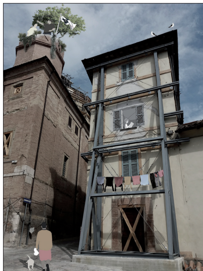
Camerino. Resti del torrino della chiesa di Santa Maria in Via e opere provvisorie post sisma 2016
