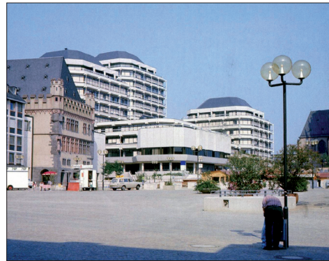
fig. 4 - Uffici Tecnici Comunali (Technisches Rathaus), 1974
