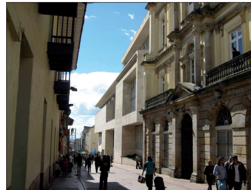
fig. 12 - Bogotá. Palacio Liévano. Ampliamento della sede municipale. Foto di Olimpia Niglio
