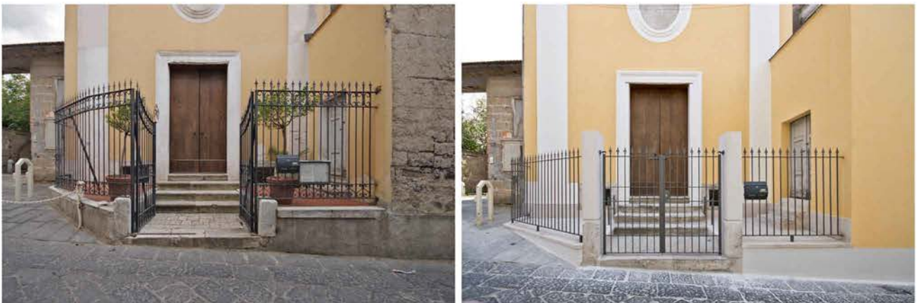
In alto: stato ante-operam e post-operam finale dei lavori di restauro della facciata principale. In basso: stato precedente ai lavori di restauro e post-lavori, in evidenza l'intervento sul sagrato d'ingresso.
