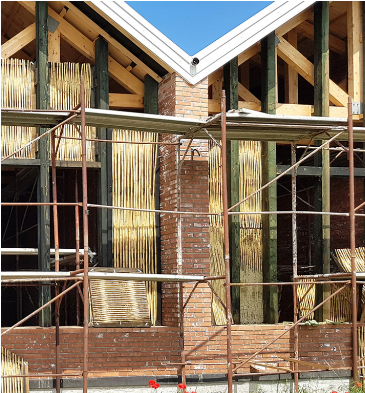
Facciata sperimentale in costruzione ©Bruno Prifti
