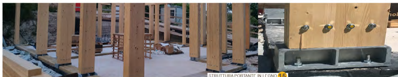
STRUTTURA PORTANTE IN LEGNO 15
