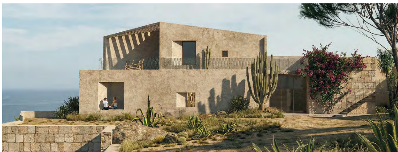
PUNTI DI VISTA SULLA CASA DEL PESCATORE Recupero di un immobile sulla costa di Capopassero - studio PD'A
